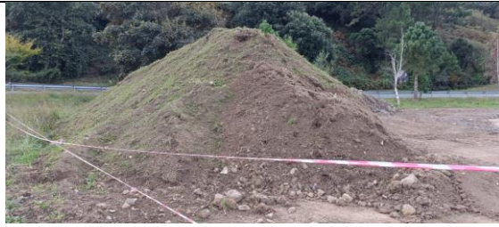
Foto 3: Acopio de tierra vegetal
