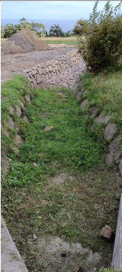
Foto 5: Prolongación del drenaje existente
